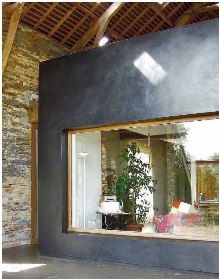
Ci-dessus, l'habitacle isolé est construit, telle une boîte indépendante, « glissée » dans une partie de l'enveloppe du bâtiment initial. Le volume restant forme un « espace tampon » habitable, entre l'intérieur et l'extérieur du bâtiment.
